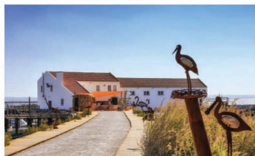
Moulin à marée dans l'estuaire du Sado
